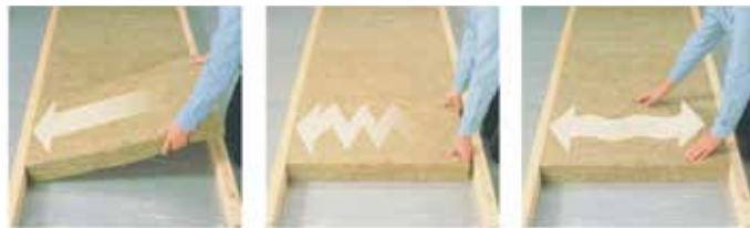
Вставьте плиту одной стороной в каркас
